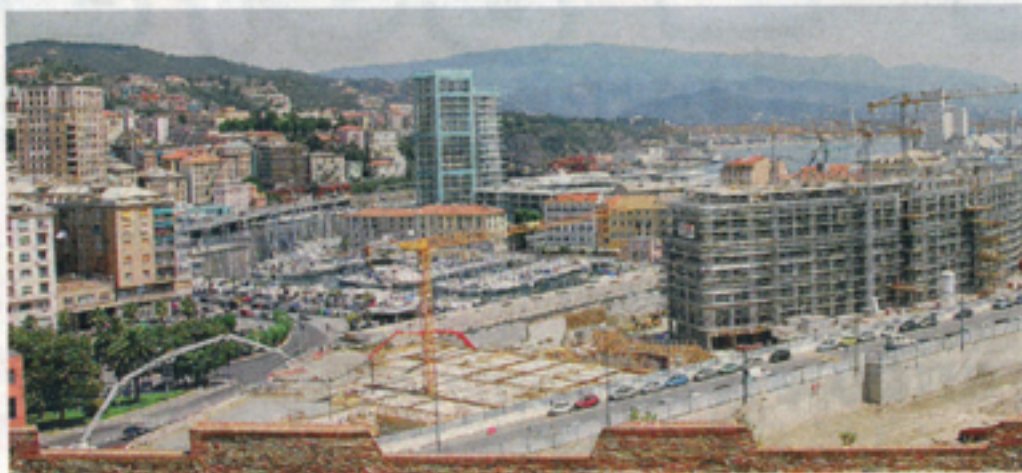
Il complesso del Crescent in costruzione nella Vecchia Darsena di Savona
